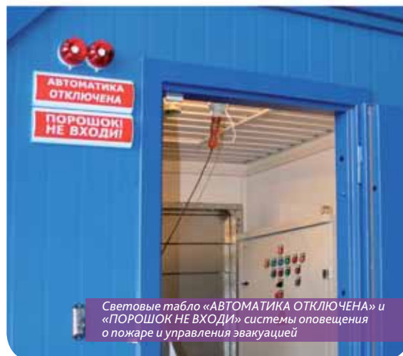
Монтаж систем охранно-пожарной сигнализации и системы автоматического пожаротушения дизельного электротягача
