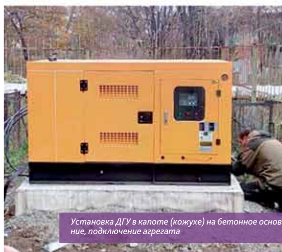
Установка дизельного электроагрегата на фундаментное основание
