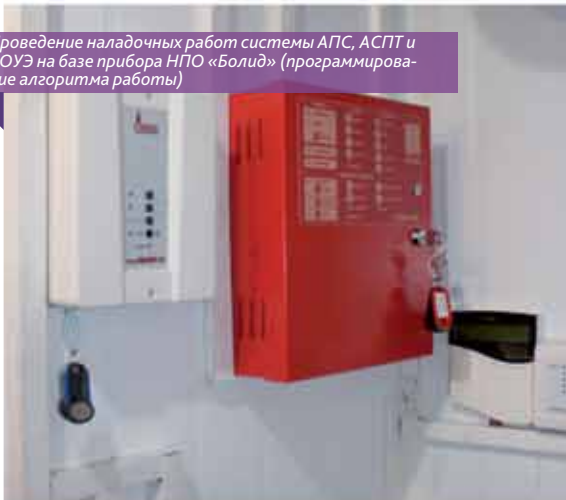
Проведение ПНР с имитацией проверки запуска модуля газового пожаротушения МГП-150 «АТАКА-1»
